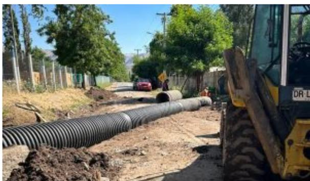
**Faenas contemplan el nuevo direccionado de las aguas, asfaltado de la calle y construcción de una vereda.**
